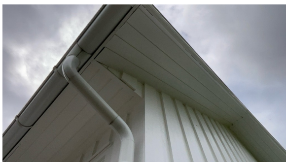
Konstruksjon sett fra terrasse.
