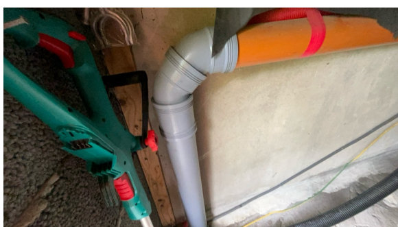
Del av rør til avløp.
