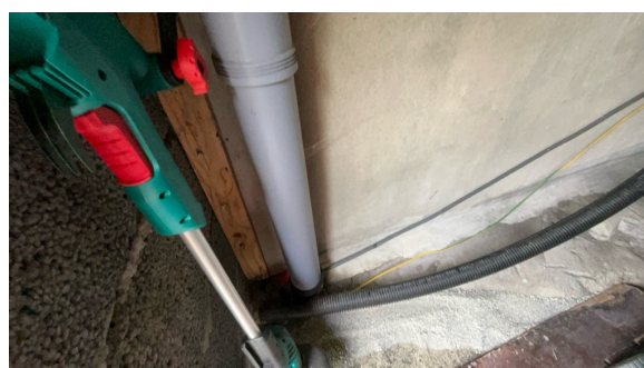
Del av rør til avløp.
