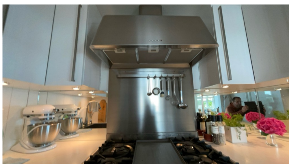
Montert avtrekk over gasskomfyr.
