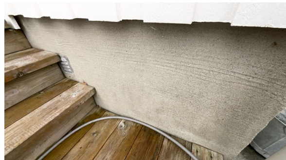
Del av grunnmur.
