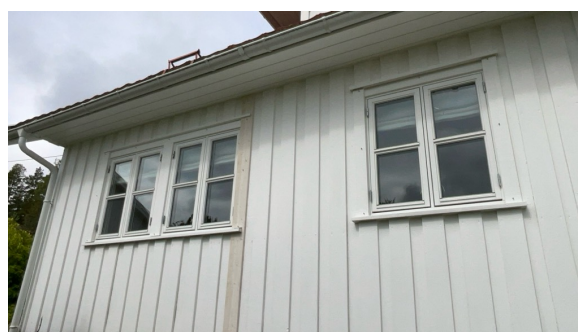
Eksempel på vindu i yttervegg.
