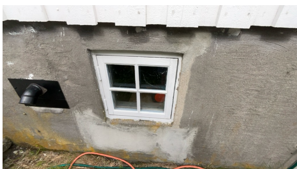
Eksempel på vindu i murvegg.
