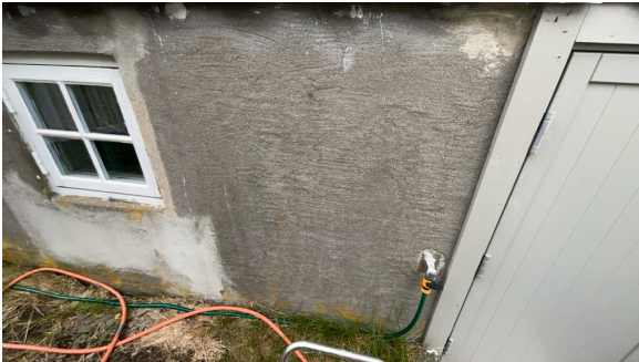
Del av grunnmur.
