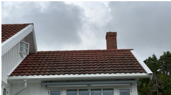
Del av taktekking.
