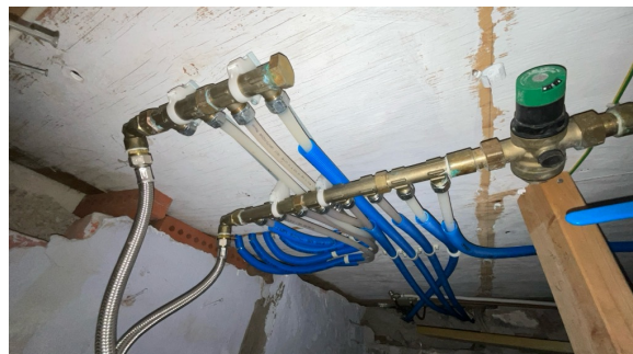
Del av rør til vann.
