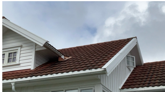
Del av taktekking.
