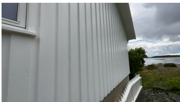
Del av vegg.
