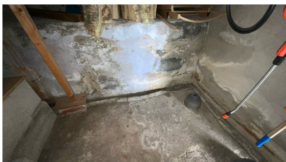
Del av rom under terreng.
