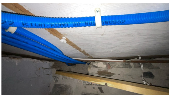
Del av rør til vann.
