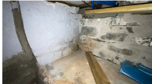
Del av grunnmur.
