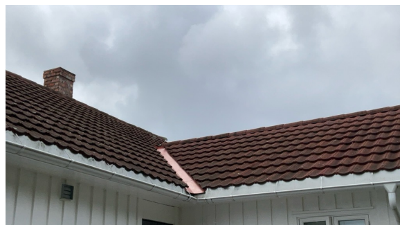
Del av taktekking.
