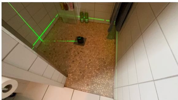
Målt fall på gulv. Del av gulv.
