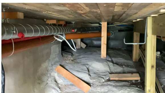
Del av rør til avløp.
