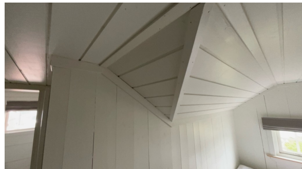
Del av vegg - tak.
