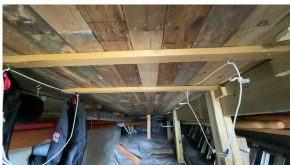
Del av etasjeskille sett fra undersiden.
