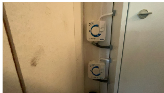
Brytere til varme på vann og avløp.
