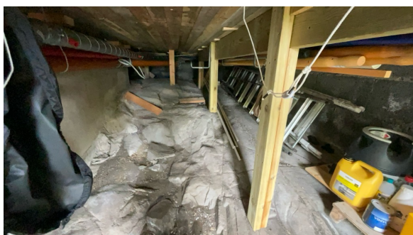
Del av krypkjeller.
