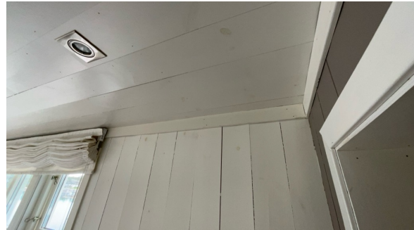
Del av vegg - tak.
