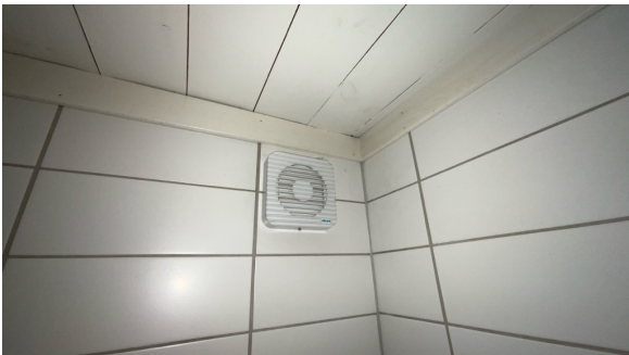
Montert avtrekk i vegg.
