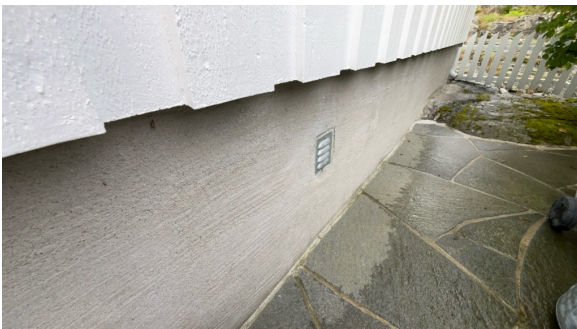
Del av grunnmur.
