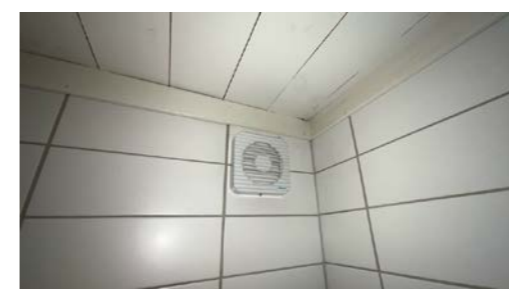
Montert avtrekk i vegg.
