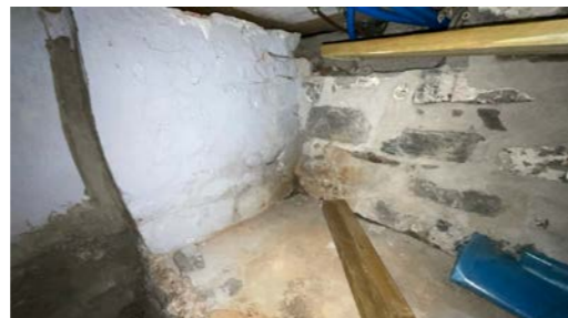
Del av grunnmur.
