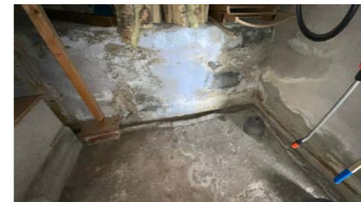
Del av rom under terreng.
