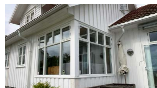
Eksempel på vindu i yttervegg.
