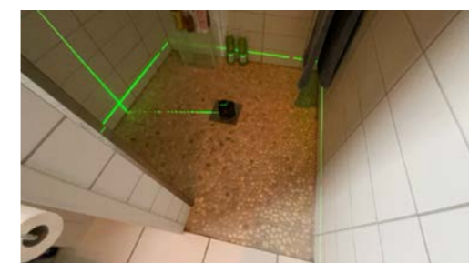
Målt fall på gulv. Del av gulv.
