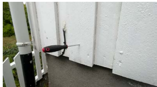
Del av vegg. Stikk kontroll av vegger er utført.
