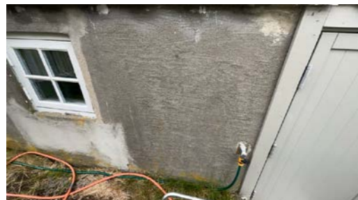
Del av grunnmur.
