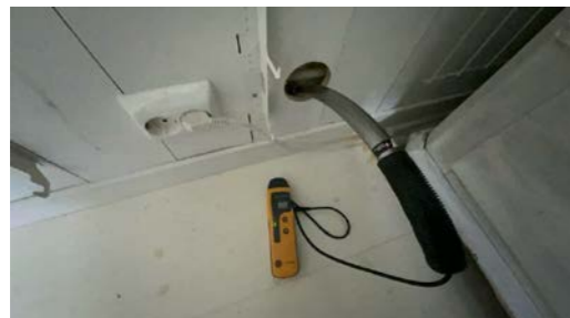
Hull for kontroll av fukt.
