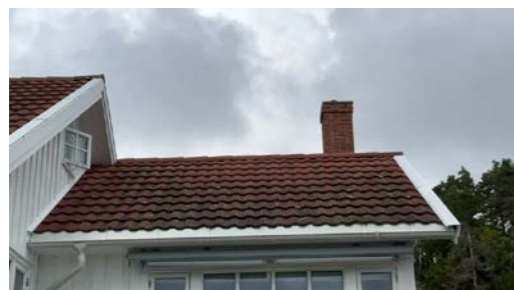
Del av taktekkning.
