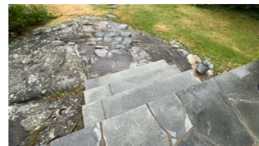
Trapp ned fra terrasse.
