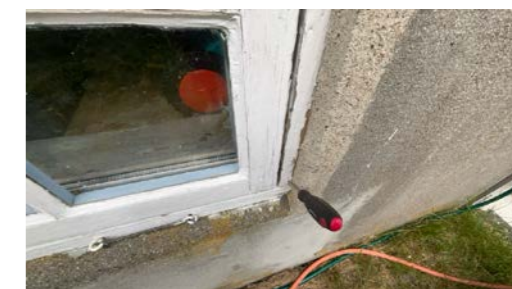
Eksempel på vindu i murvegg. Stikk kontroll på vinduer er utført.
