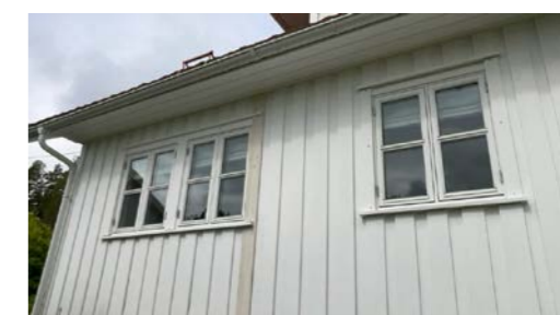
Eksempel på vindu i yttervegg.
