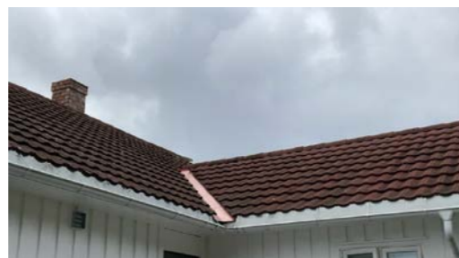
Del av taktekkning.
