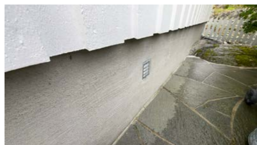
Del av grunnmur.
