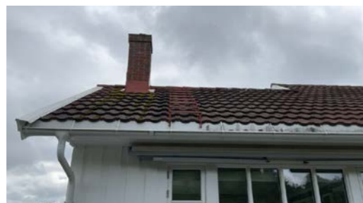
Del av taktekkning.
