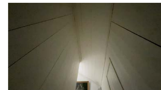
Tak sett fra innsiden.
