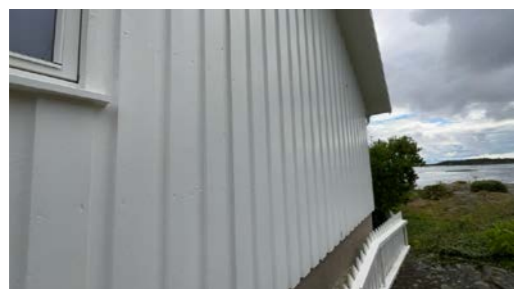
Del av vegg.
