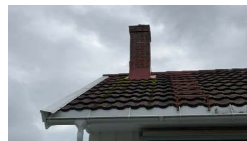
Pipebeslag. Del av rennesystem.
