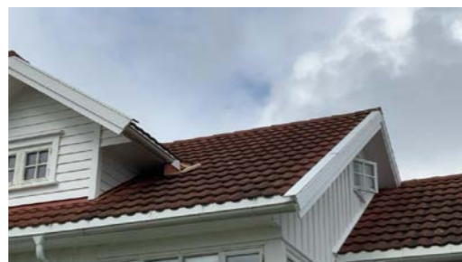
Del av taktekkning.
