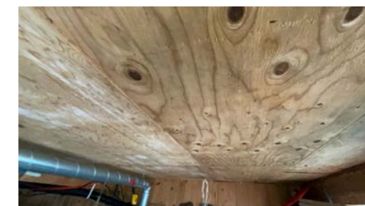
Del av etasjeskille sett fra undersiden.
