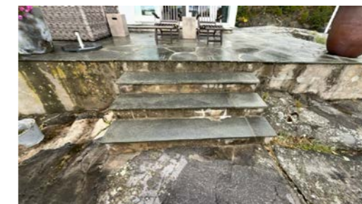
Trapp opp til terrasse.
