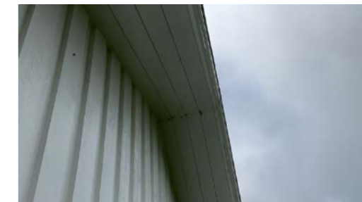
Konstruksjon sett fra terrasse.
