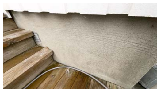
Del av grunnmur.
