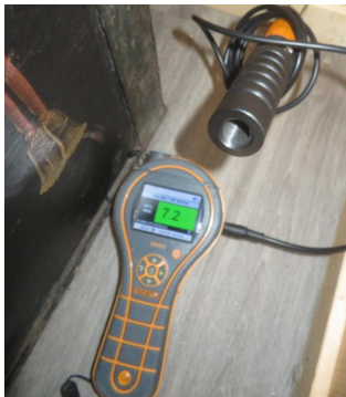
Fuktsøk fukt - Naturlige utslag - ingen forhøyede fuktverdier.
