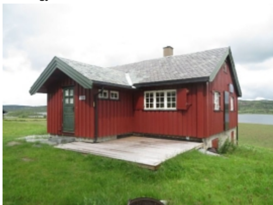
Sæl Utvendige fasader med stående tømmermannspanel til utlektet og tilleggisolert sjikt utenpå opprinnelig tømmervegg.
