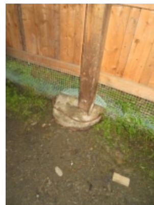
Redskapshus Støpt punktfundamenter.
