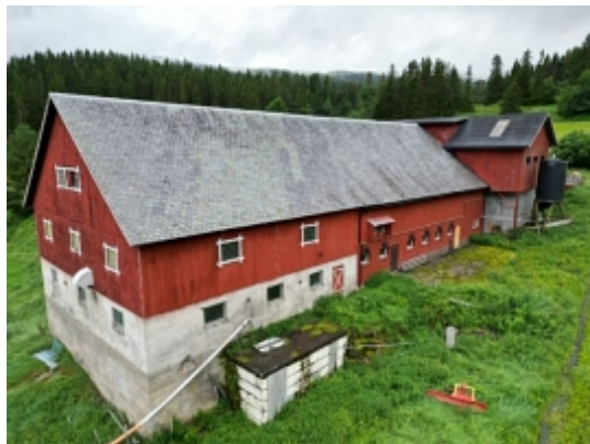
Driftsbygning Pussavskalling under vinduer og manglende omramming etter montering av vinduer. Påvist setningssprekk i veggkonstruksjonen (Skråsprekk over og under ett av vinduene). Merk behov for overflatebehandling av ytre gavlvegg.
