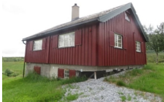
Sæl Dels noe nye ringmurssystemer på deler av bygget. Det ses benyttet platon grunnmursplast som fuktsikringspapp mot terreng.
