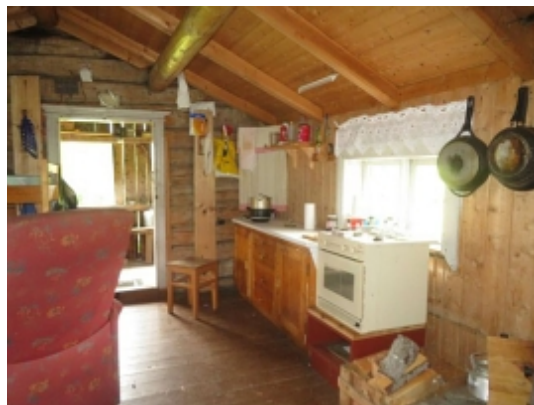
Sæl Innvendig - dels laftet tømmer, del trepanel. Uisolerte tregulv. Enkle vinduer samt labankdør.
