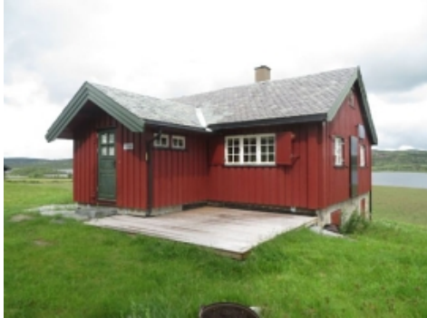
Sæl Utvendige fasader med stående tømmermannspanel til utlekket og tilleggsisolert sjikt utenpå opprinnelig tømmervegg.
