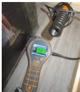
Fuktsøk fukt - Naturlige utslag - ingen forhøyede fuktverdier.
