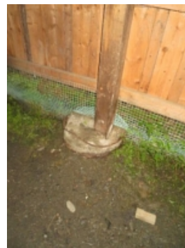
Redskapshus Støpt punktfundamenter.
