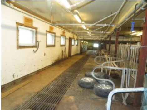
Driftsbygning Del av fjøset med rister ned i gjødselkjeller. Definerte bås plasser.
