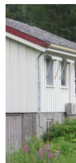
Nedløpsrør med utkast til terreng.
