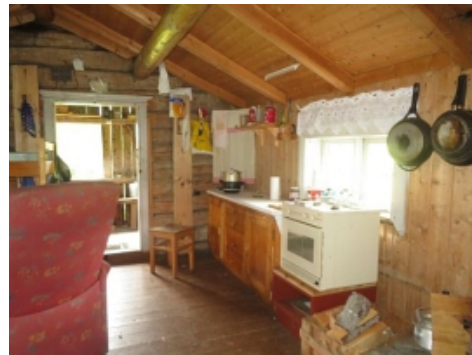
Sæl Innvendig - dels laftet tømmer, del trepanel. Uisolerte tregulv. Enkle vinduer samt tabankdør.
