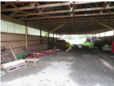
Redskapshus Del av åpent rom inne i redskapshuset. God innv. takhøyde.
