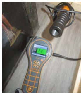
Fuktsøk fukt - Naturlige utslag - ingen forhøyede fuktverdier.
