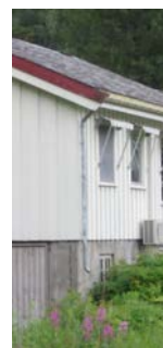
Nedløpsrør med utkast til terreng.
