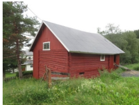
Stabbur Dels laftet, dels uisolert reisverk med stående kledning. Plateteknet saltak.
