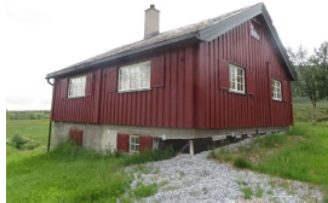
Sæl Dels noe nye ringmurssystemer på deler av bygget. Det ses benyttet platon grunnmursplast som fuktsikringspapp mot terreng.
