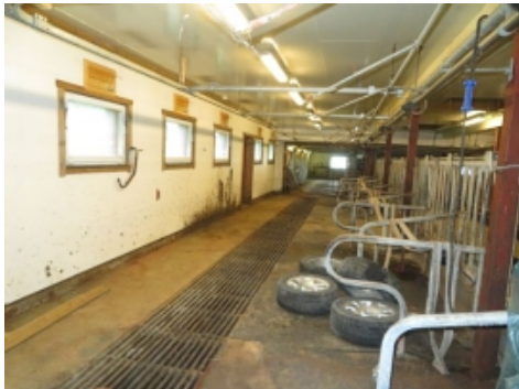
Driftsbygning Del av fjøset med rister ned i gjødselkjeller. Definerte bås plasser.
