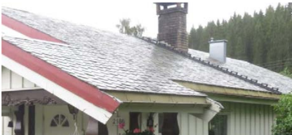
Skifertekking fra byggeår.
