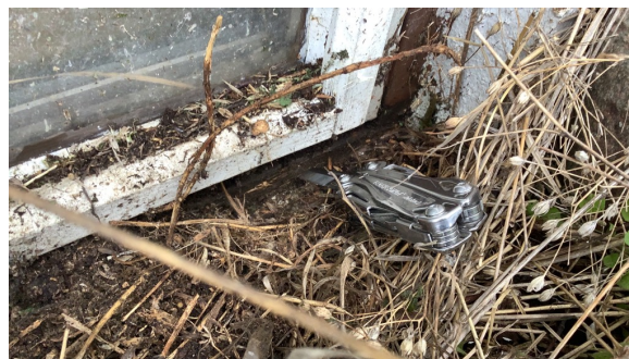
Råteskadet kjellervindu.
