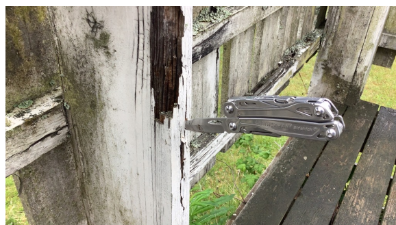
Råteskadet rekkverksstolpe.
