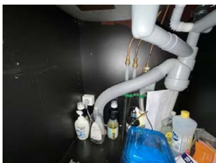
Viser vann og avløpsinstallasjoner under kum.
