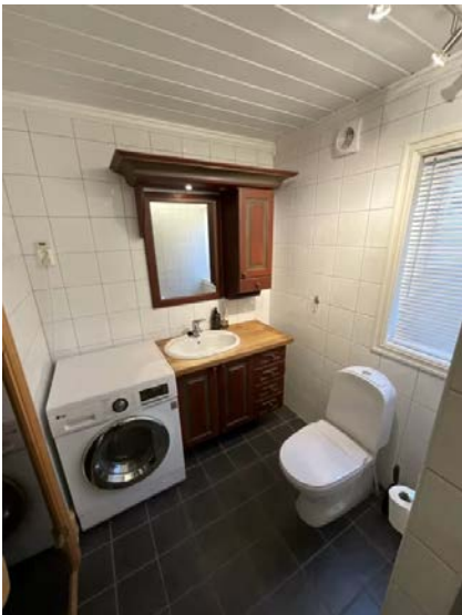
Viser baderomsinnredning opplegg for vaskemaskin og gulvstående toalett.
