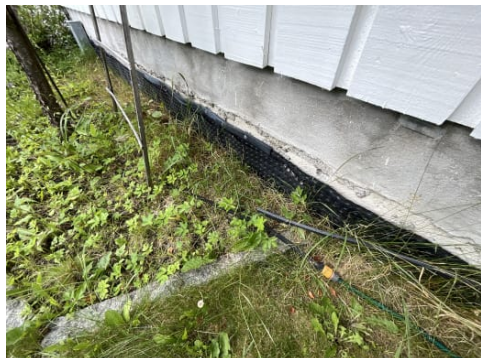
Synlig knotteplast mot sør.
