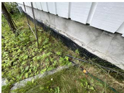
Synlig knotteplast mot sør.
