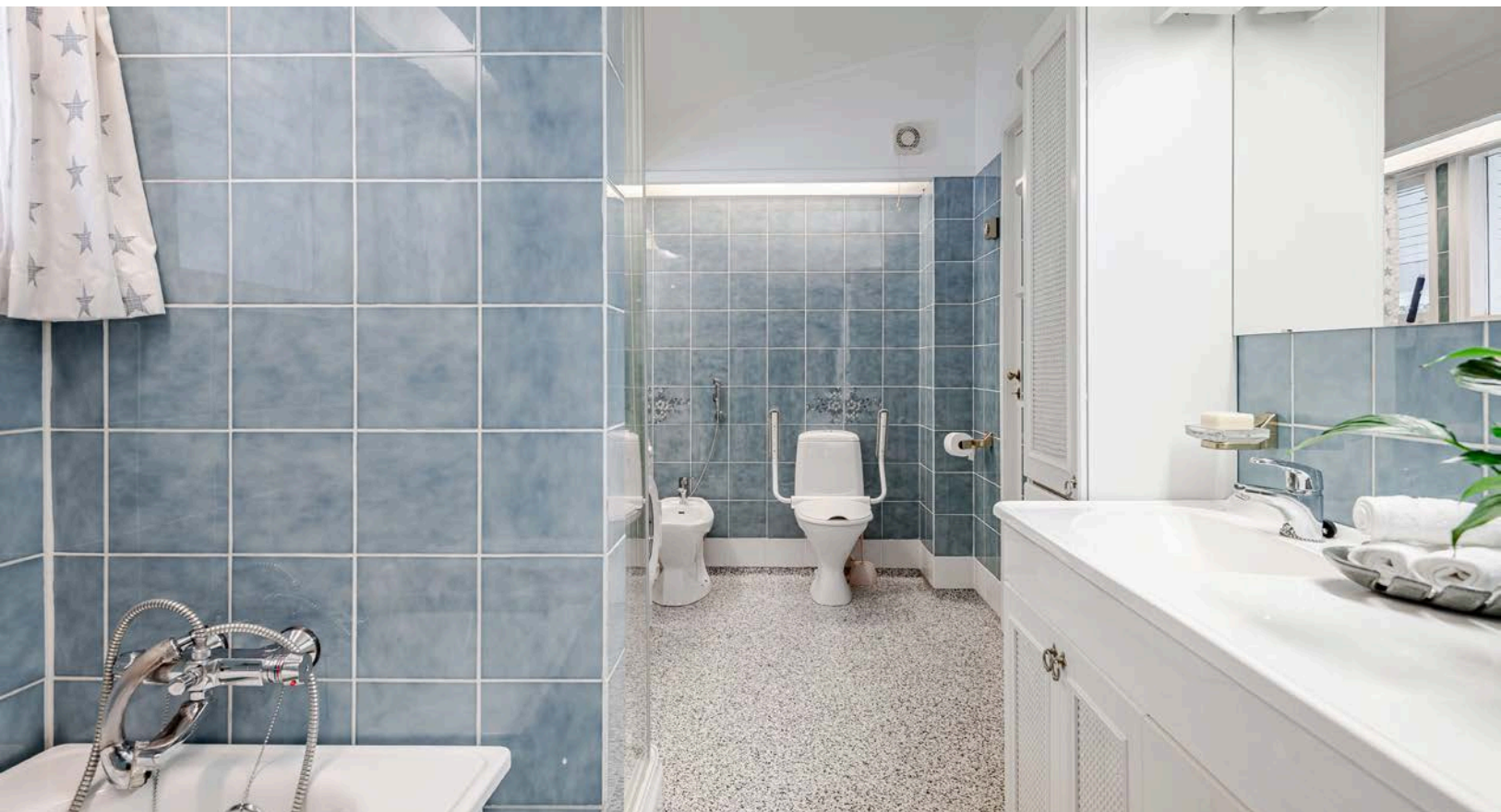
Baderommet har belegg på gulv, elektriske varmekabler, fliser på veggene og mekanisk vifte.
