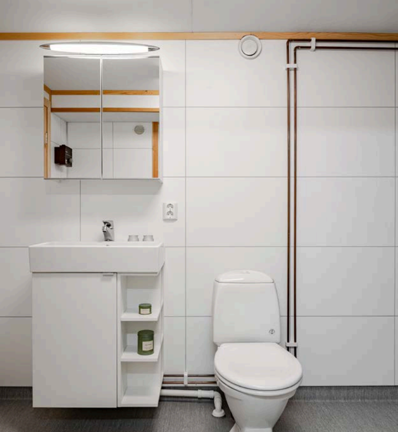
Baderommet har belegg på gulv, elektrisk gulvvarme, lyse våtromsplater på veggene og mekanisk avtrekk.
