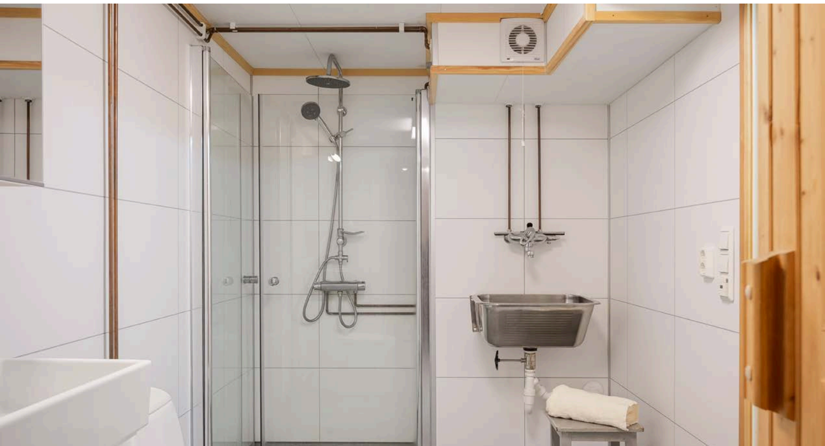
Baderommet i kjelleren er opplyst at ble pusset opp i 2012 etter en vannlekkasje.
