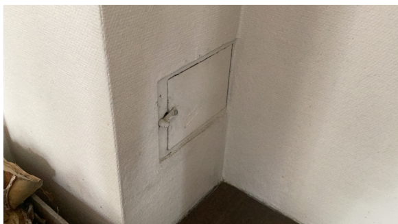
Sotluke i stue.
