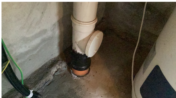
Stakepunkt i kjeller.
