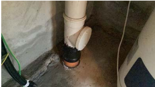
Stakepunkt i kjeller.
