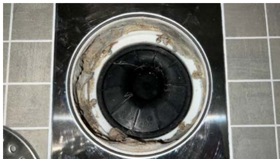
KJELLER > VASKEROM / BAD
