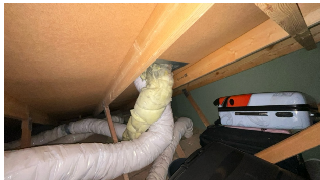
Kontroll rundt rørgjennomføringer.
