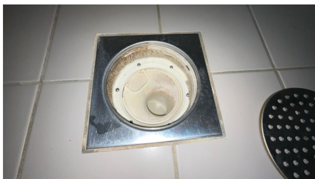
Kontroll av sluk.
