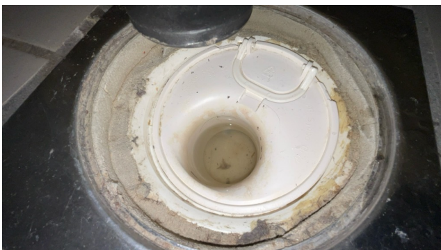
Kontroll av sluk.
