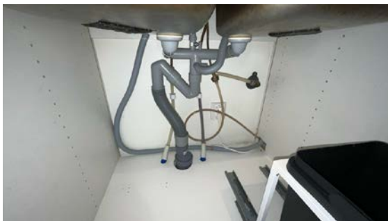
Besiktigelse av røropplegg.
