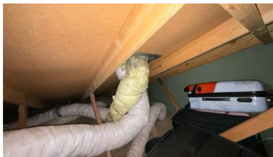
Kontroll rundt rørgjennomføringer.
