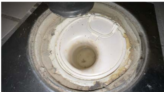
Kontroll av sluk.
