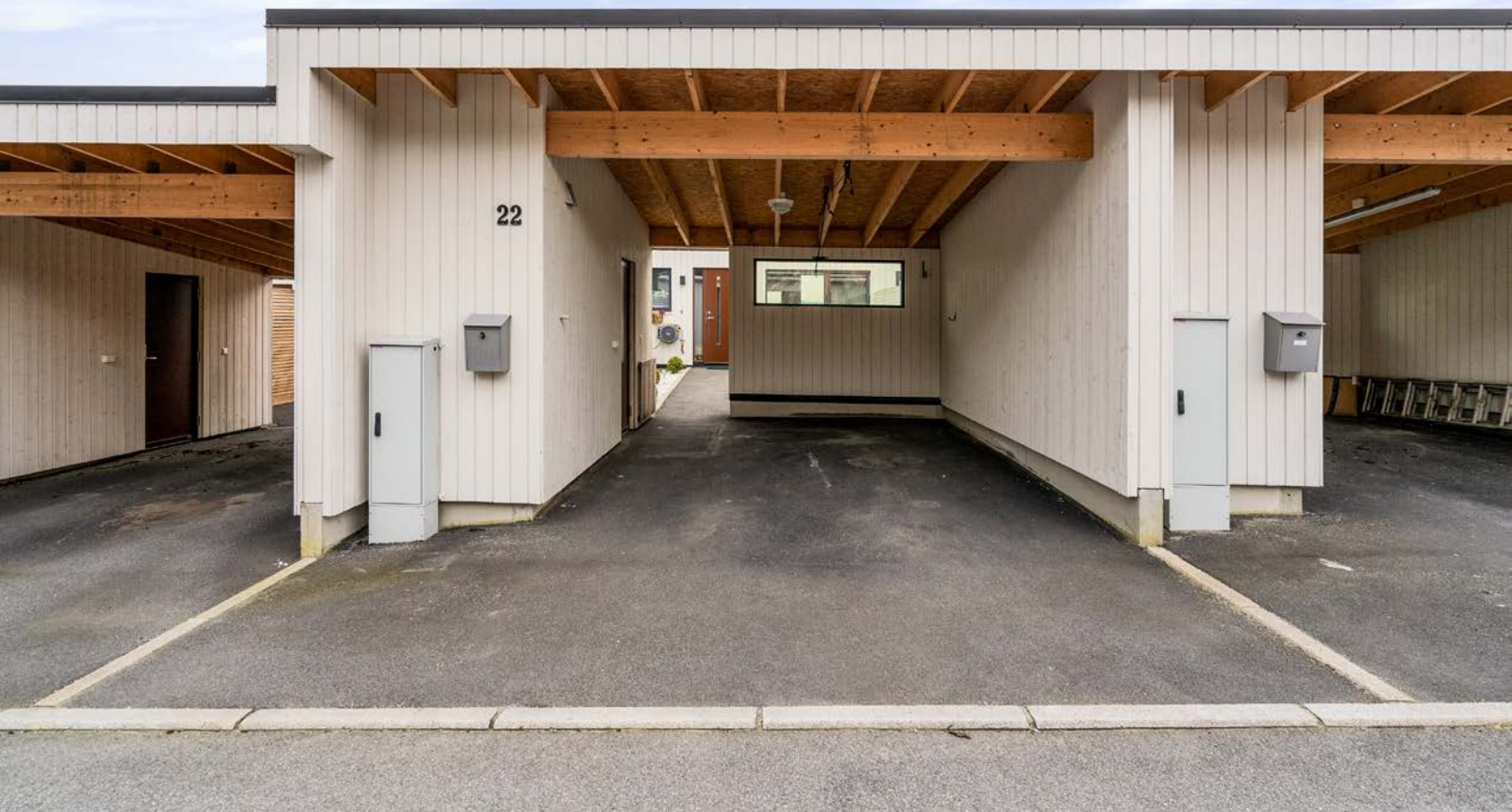
Carport med sportsbod.
