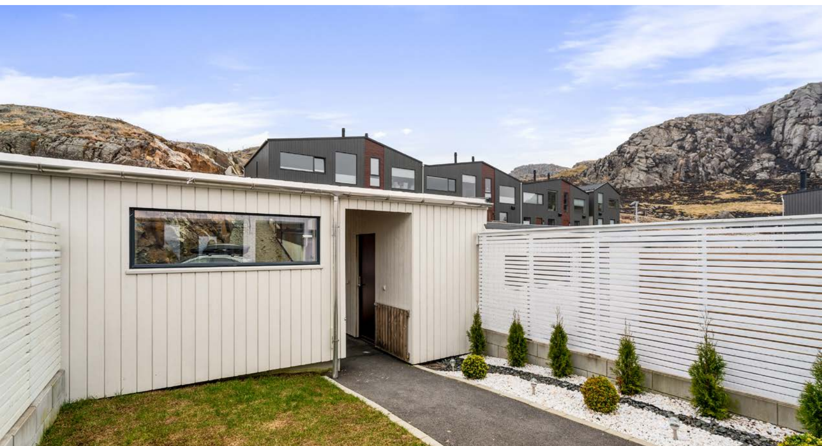
Pent opparbeidet inngangsparti med asfalt, plen og bed.
