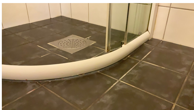
LEILIGHET I 1.ETASJE > BAD
