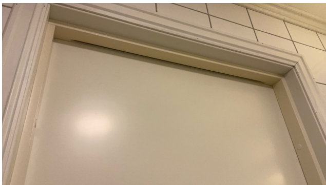
LEILIGHET I 1. ETASJE > BAD
