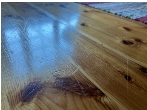
Bruksslitasje/riper på gulvoverflate
