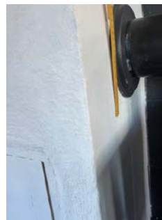
Avstand mellom sotluke og røykrør er for kort ihenhold til krav
