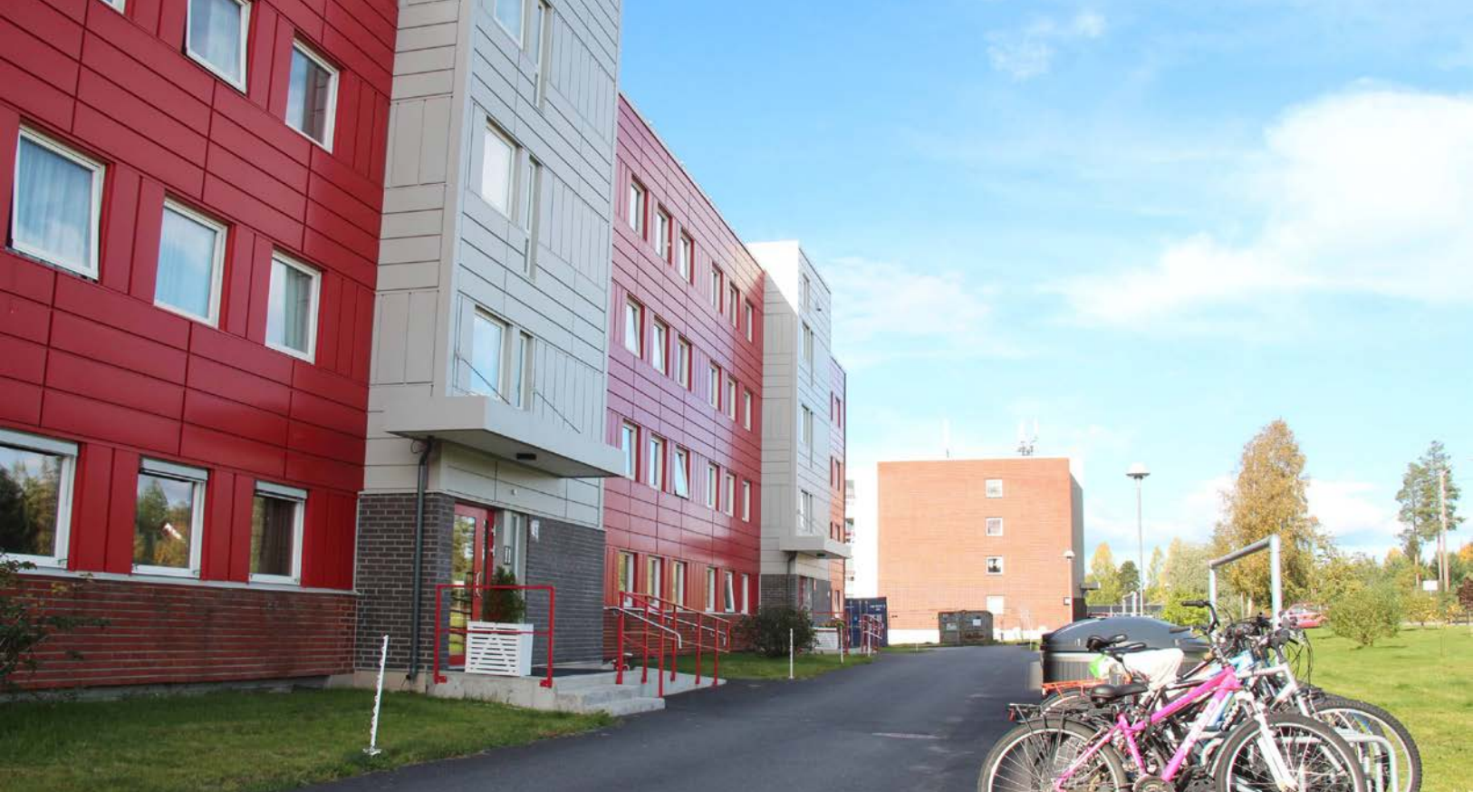
Leilighetsblokka har et trivelig, felles inngangsparti.
