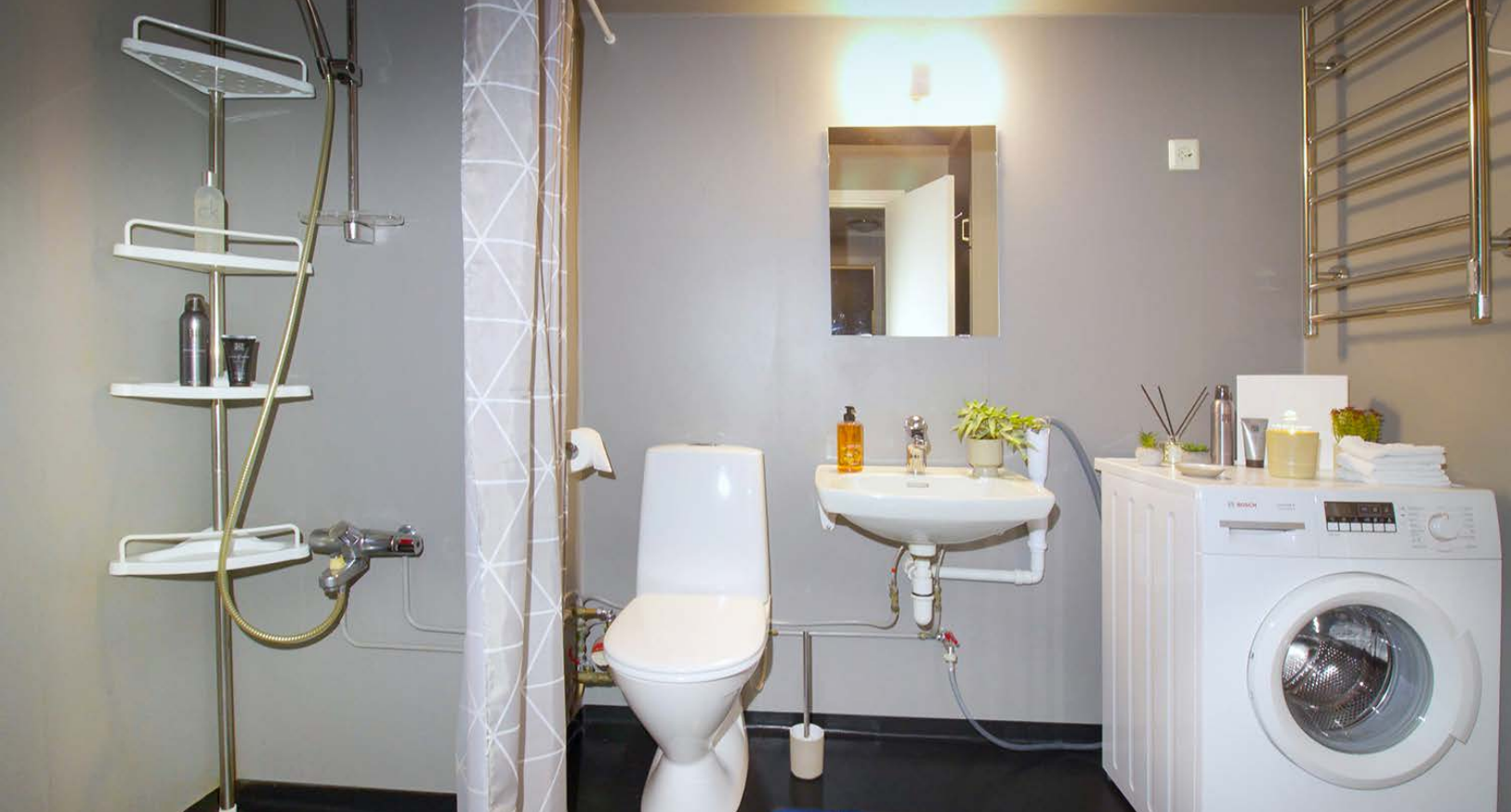
Baderom med malt belegg på gulv og vegger med malte våtromsplater.
