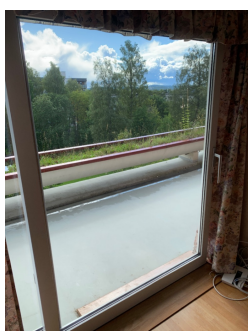
Skyvedør til terrasse med malt treramme
