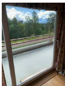
Skyvedør til terrasse med malt treramme
