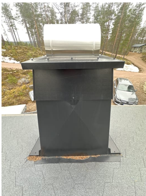
Viser pipebeslag.
