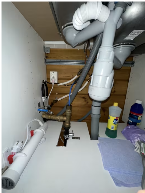
Viser vann og avløpsinstallasjoner under kum.
