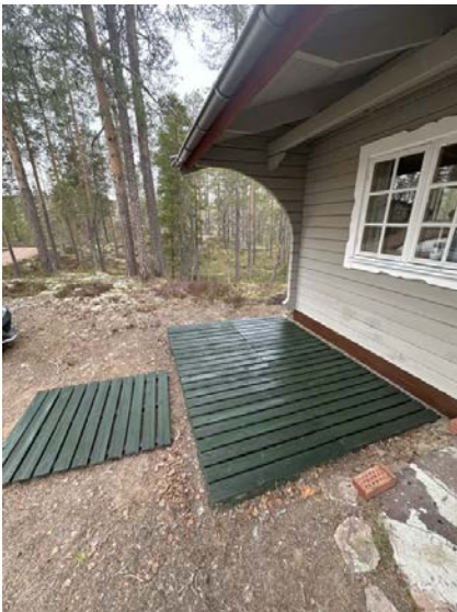
Viser platting mot sør/vest
