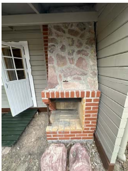
Viser utvendig åpen peis.
