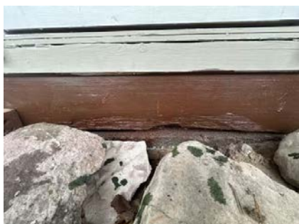
Trevirke med tidligere råteskade behandlet godt med beis. Antatt fuktoppptrekk fra grunnmur eller
