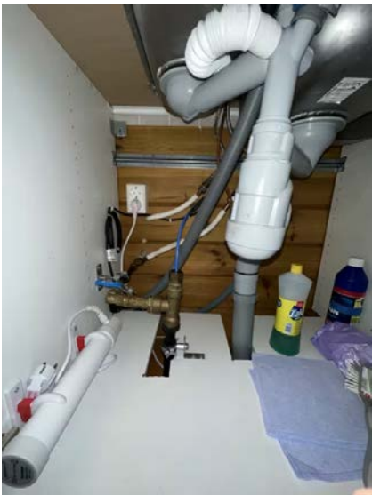
Viser vann og avløpsinstallasjoner under kum.
