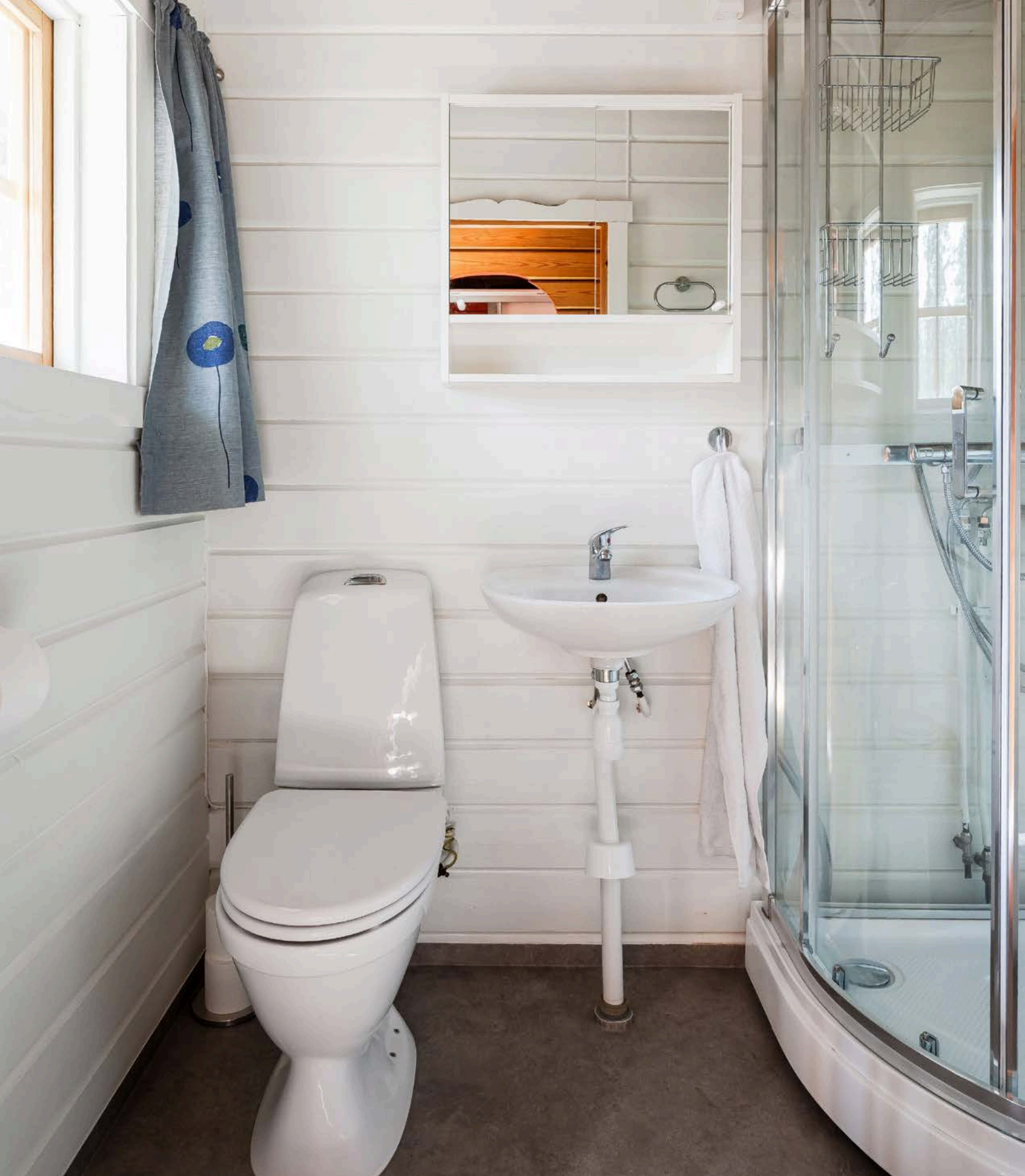
Badet ligger rett innenfor døren og er oppusset i ca 2019. Det er nyere belegg på gulv, samt malte veggflater. Innredning med wc, vegghengt servant med speilskap, samt dusjkabinett.
