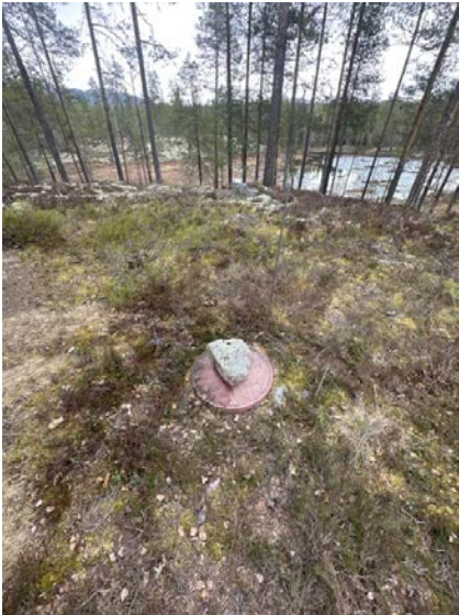
Viser utvendig kum. Ikke inspisert.
