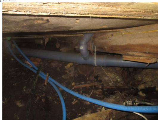
Deler av krypkjeller.
