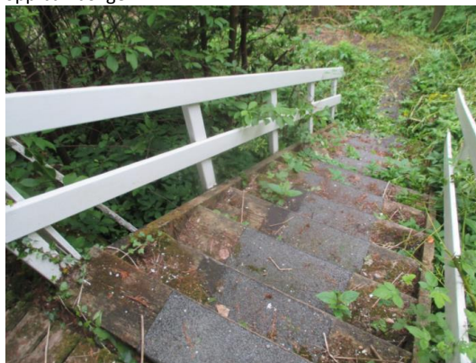
Del av trapp i mot garasje.
