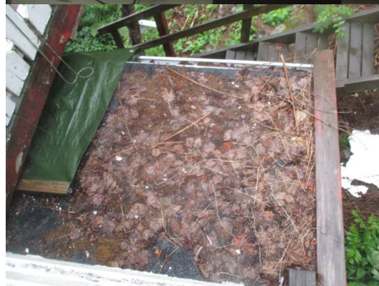
Takoverbygg ved inngangsparti.
