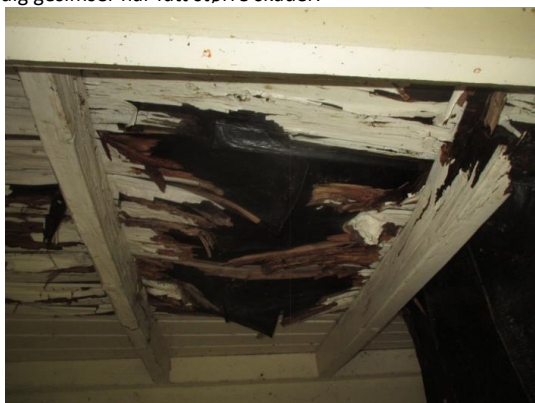
Undertak over inngangsparti.
