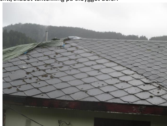
Eldre slitt/skadet takteking på tilbygget deler.
