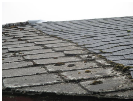
Eldre slitt/skadet takteking på tilbygget deler.
