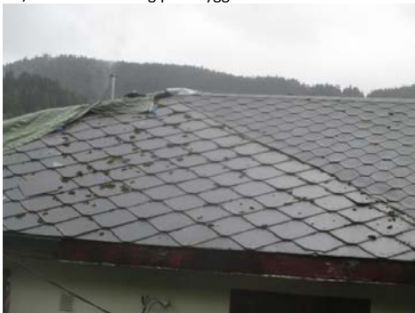
Eldre slitt/skadet taktekkig på tilbygget deler.
