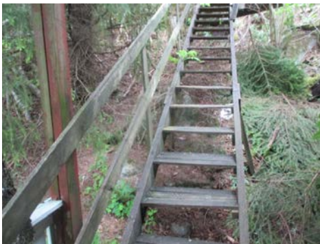
Trapp opp bak boligen
