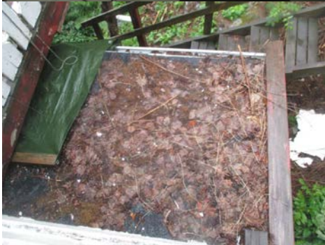
Takoverbygg ved inngangsparti.
