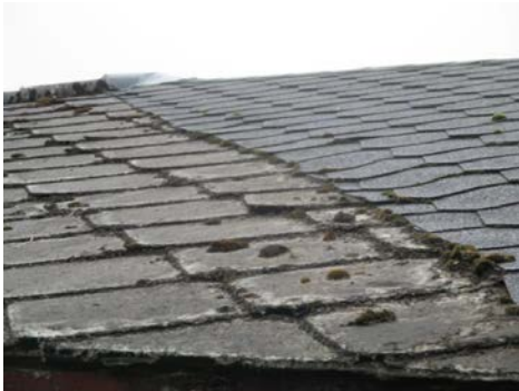
Eldre slitt/skadet taktekkig på tilbygget deler.
