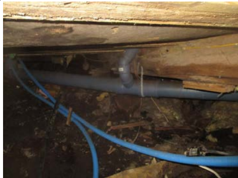
Deler av krypkjeller.
