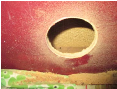
Hulltaking i fra kjøkken.
