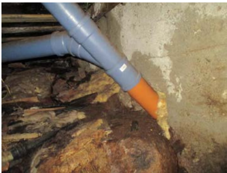
Er skiftet til plastrør i store deler av krypkjeller og ut av boligen.
