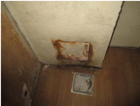
Eldre skadet sotluke.
