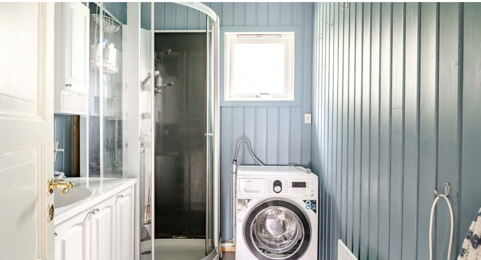
Baderommet som ble pusset opp i ca. 2004 har våtromsbelegg på gulv, malt panel på veggene og opplegg for vaskemaskin.
