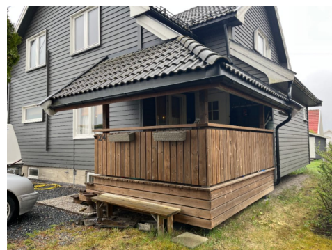
Terrasse ved inngangsparti.
