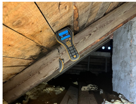
Fuktmåling viste normale verdier.
