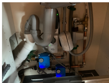
Rørapplegget i kjøkkenet. Synlig waterguard
