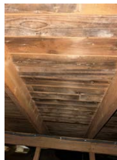
Svertesopp i undertak mot vest
