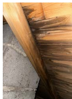
Svertesopp i undertak mot vest
