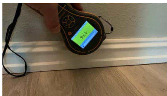
Ved overflatesøk med fuktmåler på murkonstruksjoner mot terreng var det ikke utslag av fukt fra gang ved bad, men bør holdes under tilsyn
