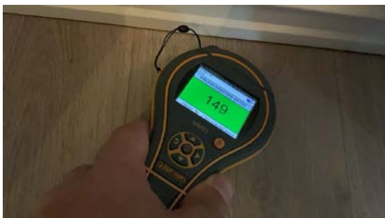
På gulv mot grunn fra gang ved bad var det ikke utslag
