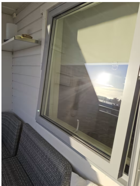
Vinduer er utvendig beslått med metall.
