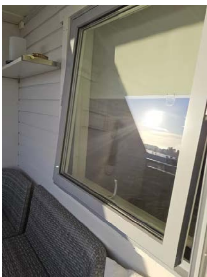
Vinduer er utvendig beslått med metall.
