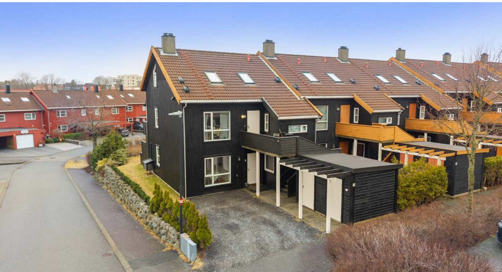
Inngangsparti med sportsbod like ved.
