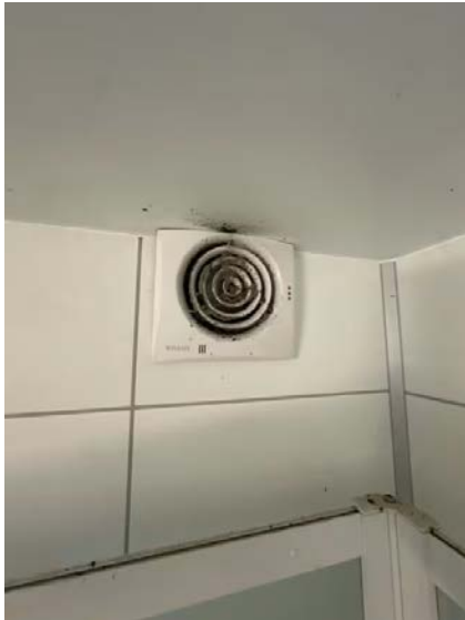
Mekanisk vifte må rengjøres.
