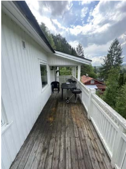
Viser delvis overbygget balkong med adkomst fra stue 2.etasje
