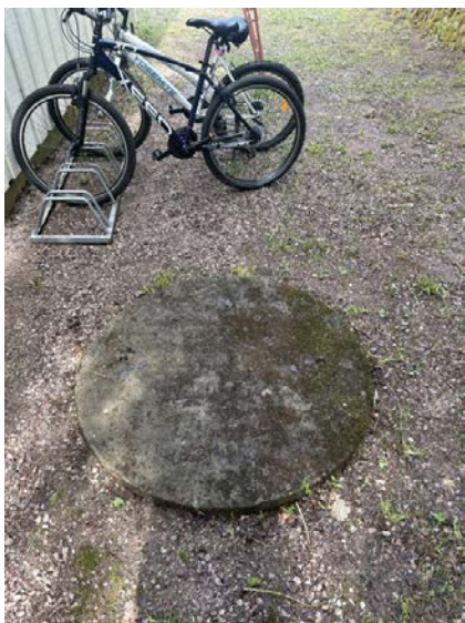
Viser utvendig kum.
