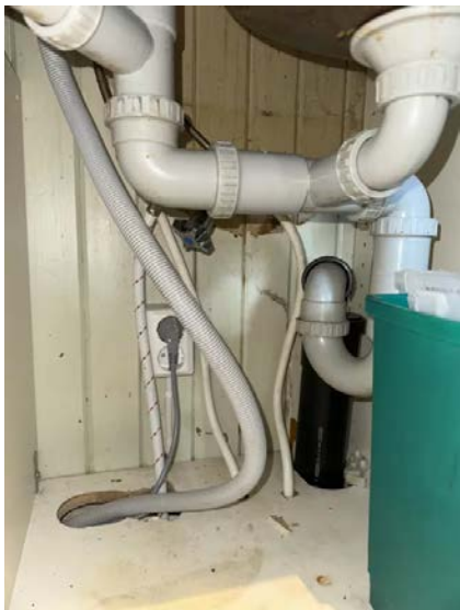
Viser vann og avløpsinstallasjoner under kum.
