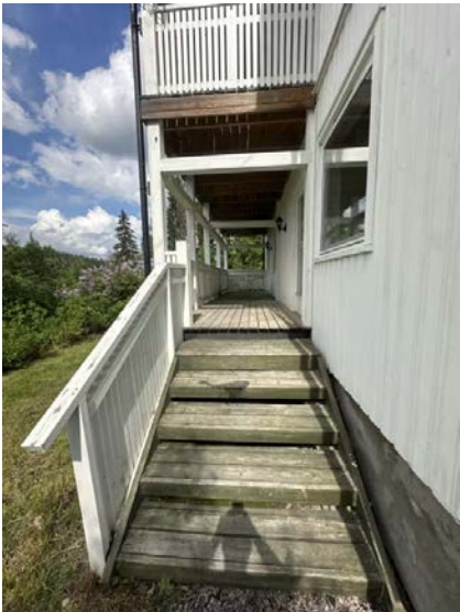
Viser balkong med adkomst fra stue og terreng ved 1.etasje.
