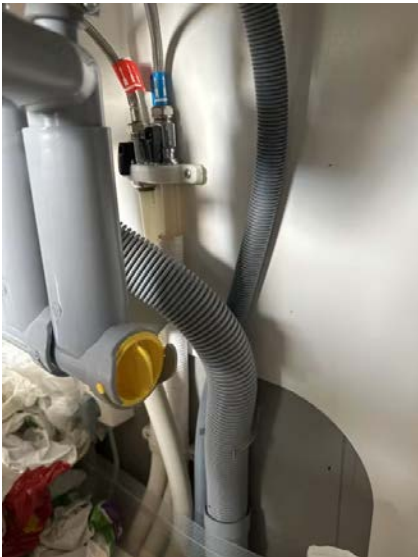
Viser vann og avløpsinstallasjoner under kum.
