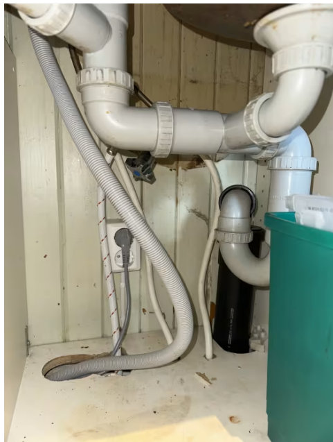
Viser vann og avløpsinstallasjoner under kum.
