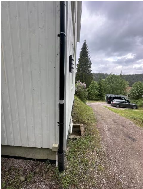
Viser nedløpsrør ført videre i drensør.
