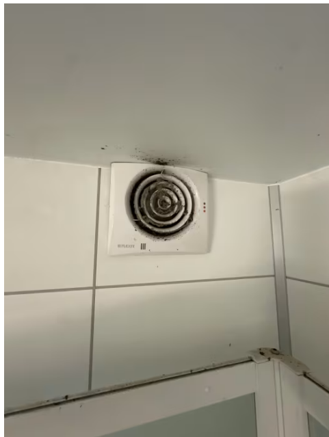
Mekanisk vifte må rengjøres.
