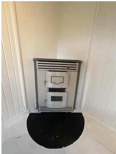
Ildsted i stue 1.etasje med kombiovn for olje og vedfyring.
