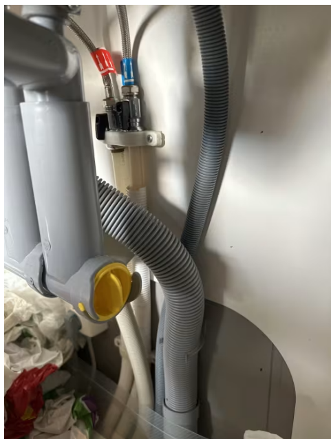
Viser vann og avløpsinstallasjoner under kum.
