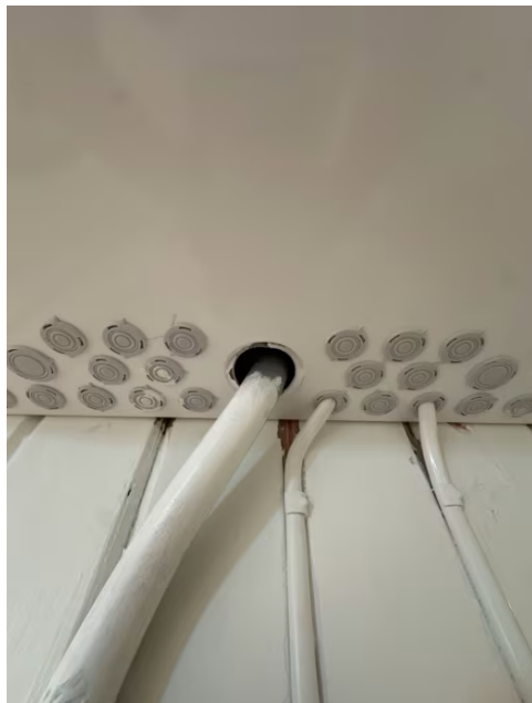
Det er hull/innføringer i inntak eller sikringsskap som ikke har nippelinnføringer eller er tett med masse beregnet for formålet.
