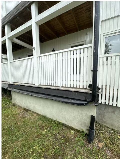
Viser skader på renner og nedløp. Nedløpsrør ikke tilknyttet drensrør.
