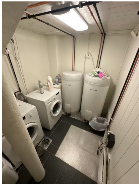
Viser vaskerom i kjeller.
