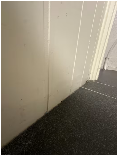
Det registreres svelleskade på mdf plater
