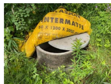
Brønn med støpt betongring/tank. Beliggende på nordsiden av uthuset.
