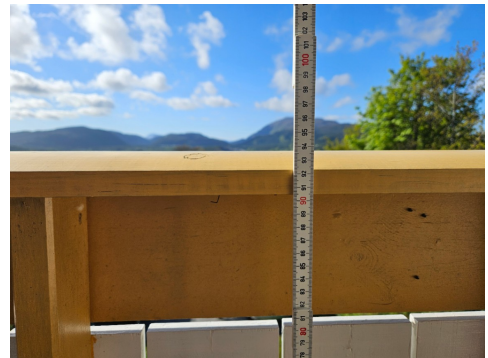
Rekkverk målt til 94 cm
