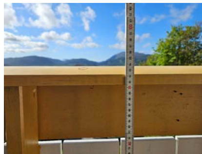
Rekkverk målt til 94 cm
