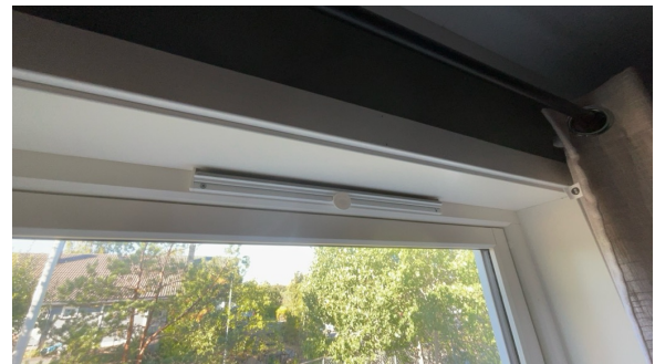
Eksempel på montert ventil i vindu.
