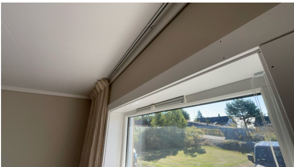
Eksempel på montert ventil i vindu.
