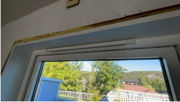
Eksempel på montert ventil i vindu.
