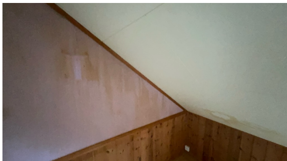
Del av vegg - tak.
