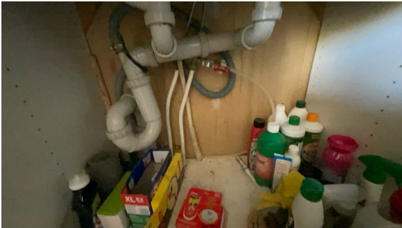
Del av rør til vann.
