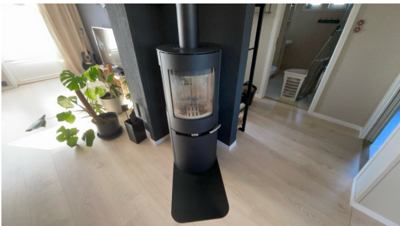
Montert ovn i stue.
