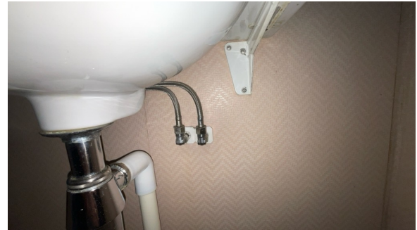
Del av rør til vann.
