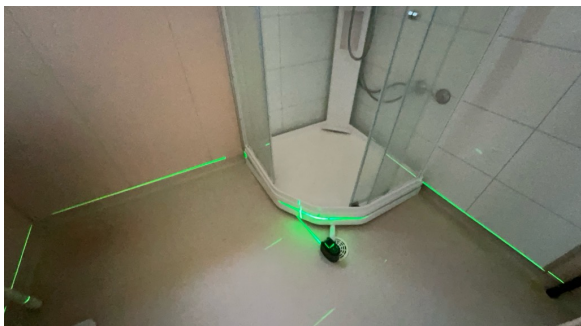
Del av badrom/vaskerom.
