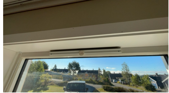
Eksempel på montert ventil i vindu.
