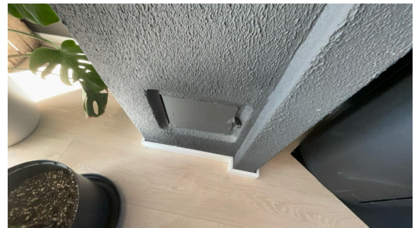
Del av pipe. Feieluke.
