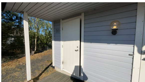
Dør inn til bod.
