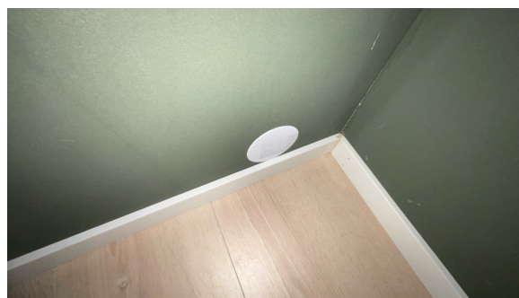
Lokk over hull.
