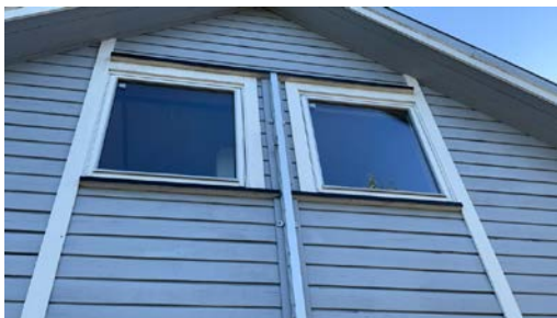
Eksempel på vindu i yttervegg.
