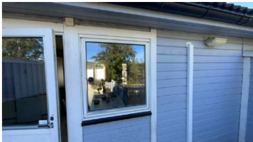
Eksempel på vindu i yttervegg.
