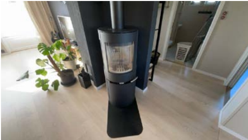
Montert ovn i stue.
