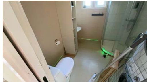
Del av badrom/vaskerom.
