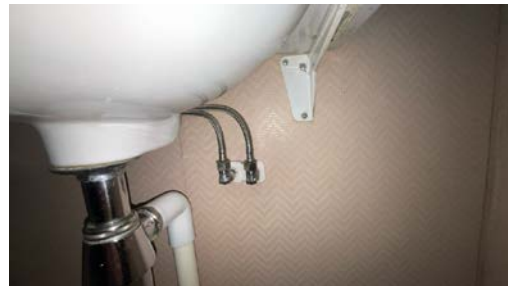
Del av rør til vann.
