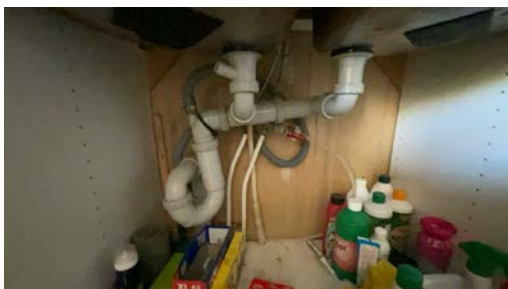
Del av rør til avløp.
