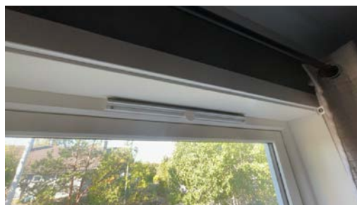
Eksempel på montert ventil i vindu.
