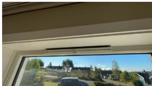
Eksempel på montert ventil i vindu.
