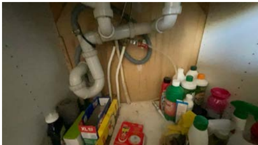
Del av rør til vann.
