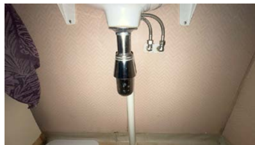
Del av rør til avløp.
