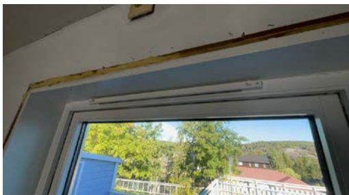
Eksempel på montert ventil i vindu.
