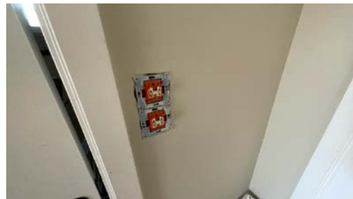
Eksempel elektrisk komponent som ikke har montert lokk.
