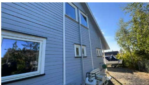
Stige for rømming ved brann.
