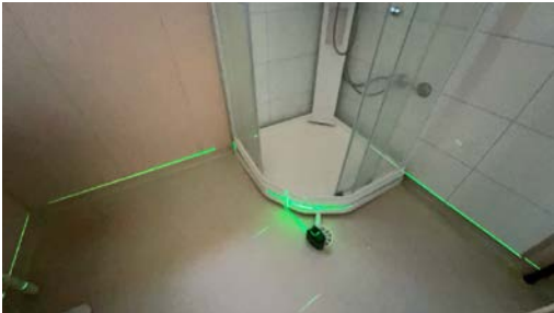
Del av badrom/vaskerom.
