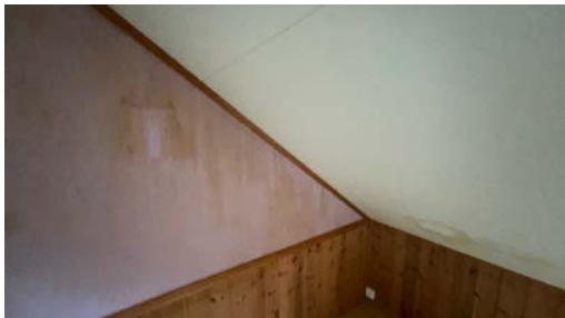
Del av vegg - tak.
