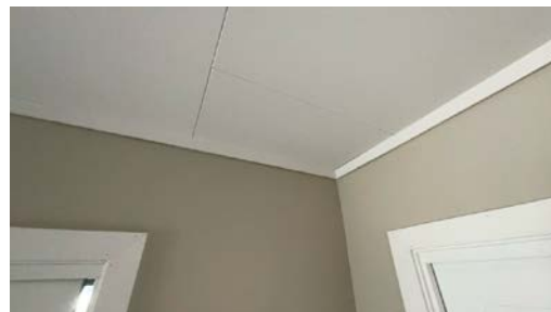
Del av vegg - tak.
