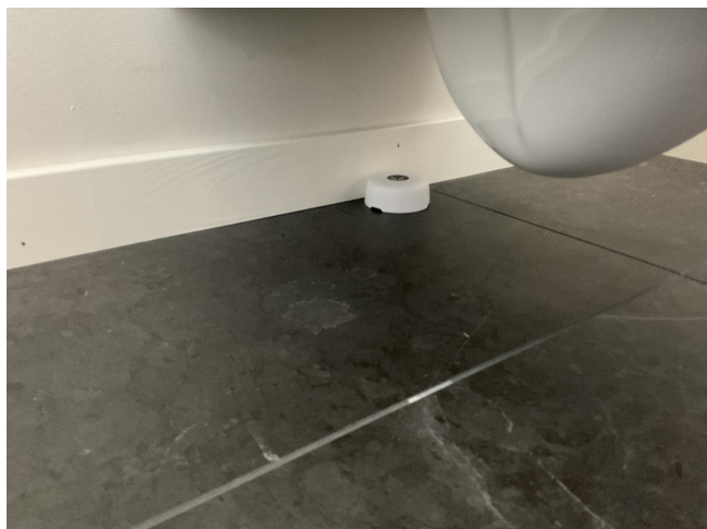
Løstliggende sensor for automatisk vannstopper.
