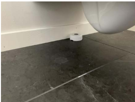
Løstliggende sensor for automatisk vannstopper.
