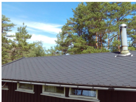
Deler av nyere taktekking
