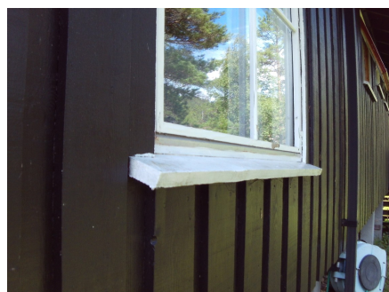
Deler av kledningen med tilhørende belistninger.
