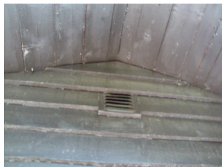
Ventil i begge gavlvegger.
