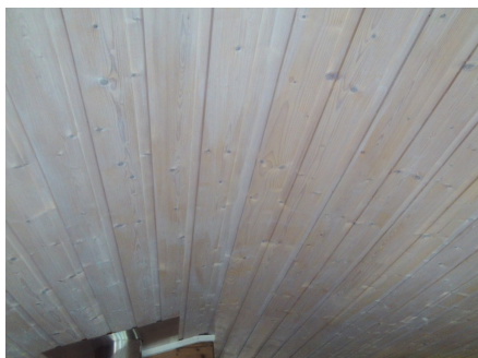
Hele takkonstruksjonen er en lukket konstruksjon.
