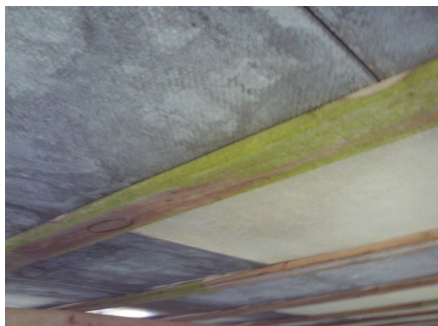
Deler av underliggende stubbloft
