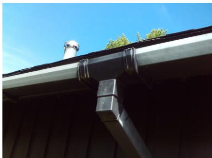
Deler av eldre takrenner med tilhørende deler.
