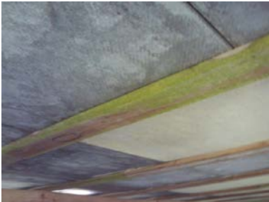
Deler av underliggende stubbloft
