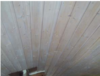
Hele takkonstruksjonen er en lukket konstruksjon.
