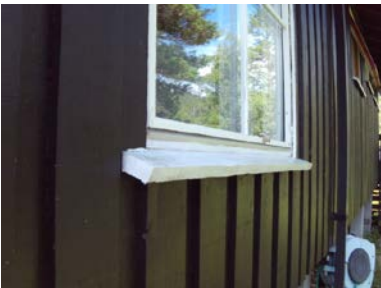
Deler av kledningen med tilhørende belistninger.
