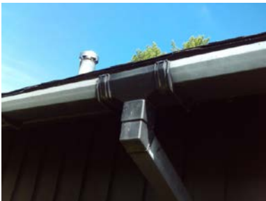
Deler av eldre takrenner med tilhørende deler.
