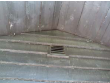
Ventil i begge gavlvegger.
