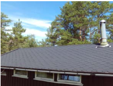
Deler av nyere taktekkning
