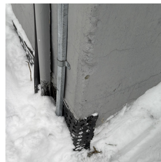
Synlig grunnmursplate vegg sør i mot tilbygg
