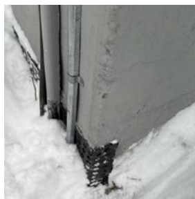
Synlig grunnmursplate vegg sør i mot tilbygg
