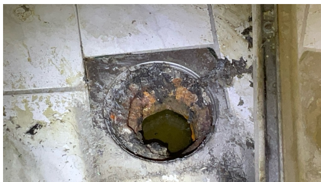
Eldre støpejernsluk i gulv, uten synlig membran.
